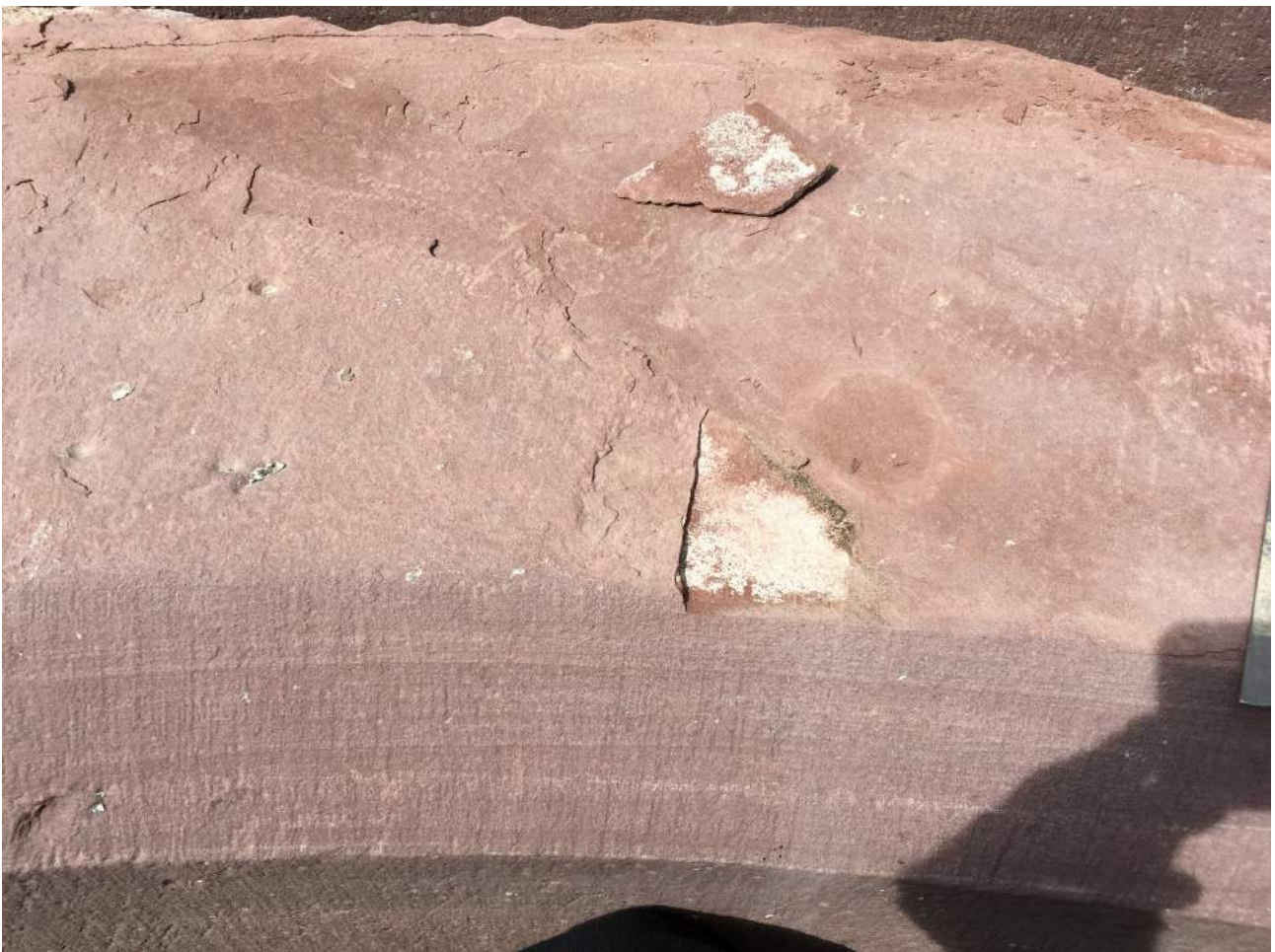
3.) Schalenbildung und Abschuppungen an dem Bogensegment L 2 und L 3
