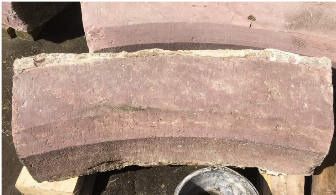
Oberes Bogensegment links (L 3) nach Freilegung im IOS – Verfahren
