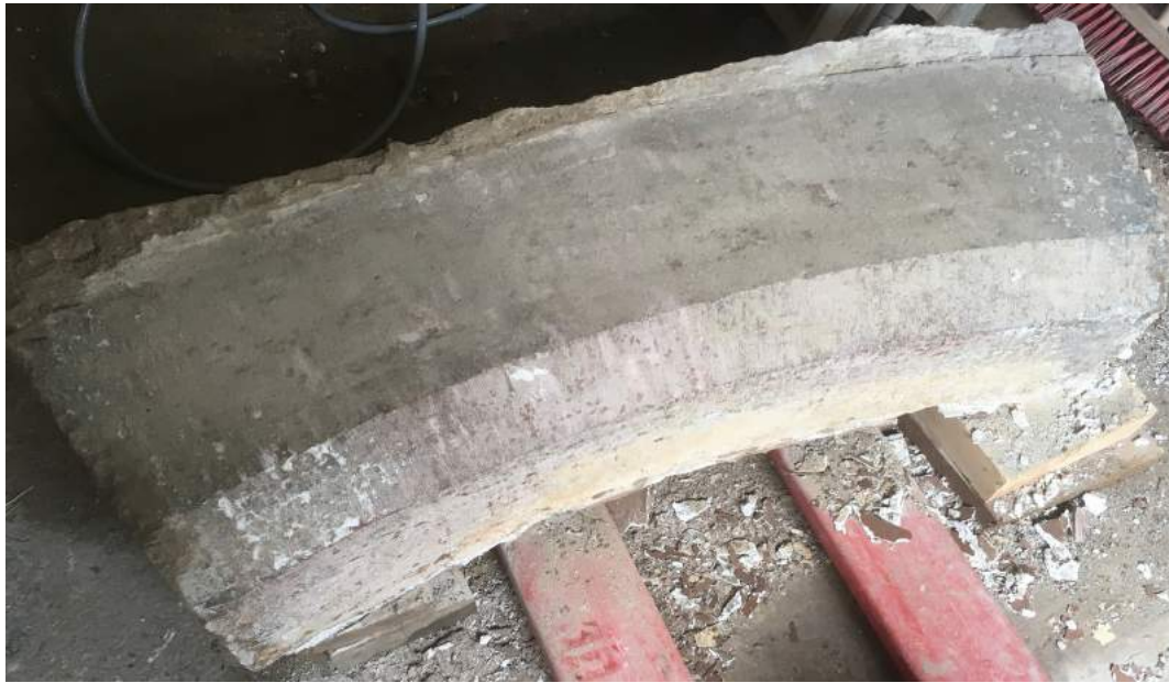
Oberes Bogensegment links (L 3)- nach manueller Freilegung der oberen 2 Farbschichten
