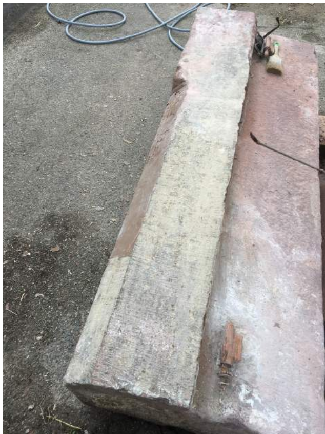
Gewände (Kämpfer) rechte Seite (R1) – während und nach der kompletten Freilegung (im IOS-Verfahren)
