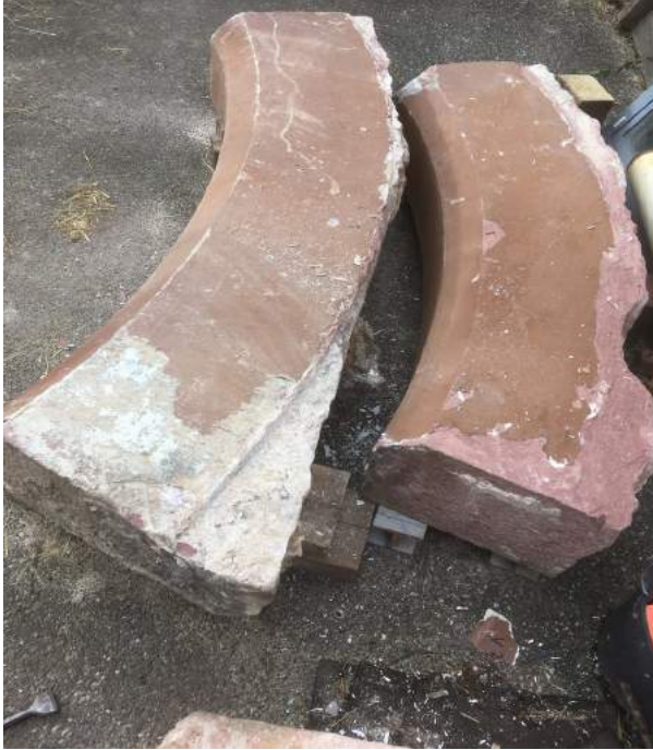
Bogensegment R2 und L3 – teilweise sind unter der Beschichtung abschuppende Bereiche vorhanden (L3)
