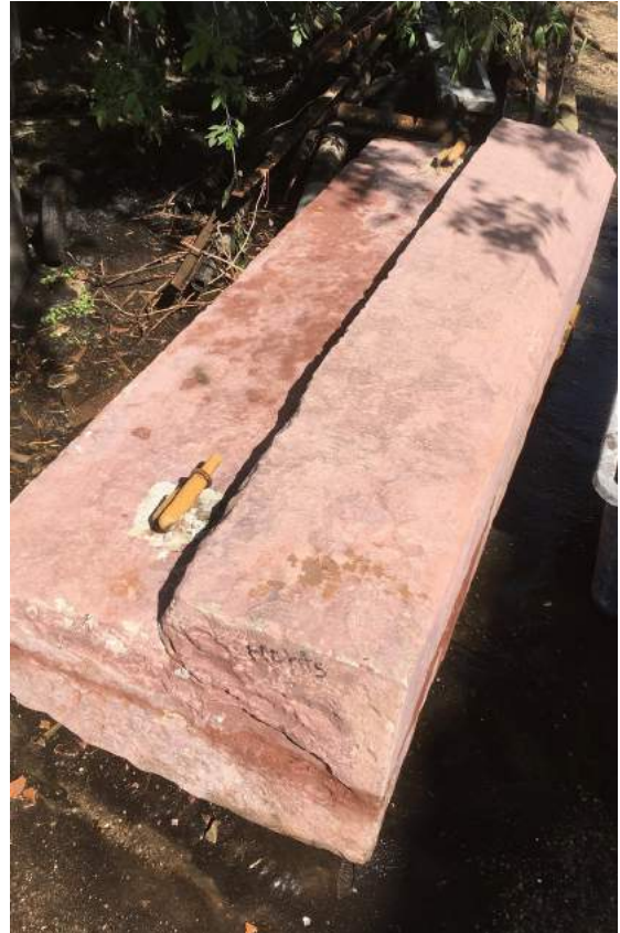
Gewände (Kämpfer) rechte Seite (R1) – während und nach der kompletten Freilegung (im IOS-Verfahren)
