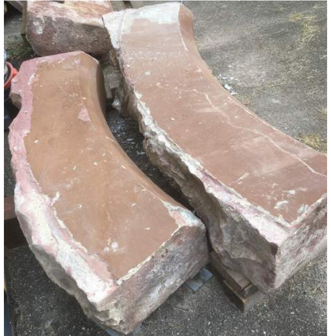
Bogensegment R2 und L3 – teilweise sind unter der Beschichtung abschuppende Bereiche vorhanden (L3)
