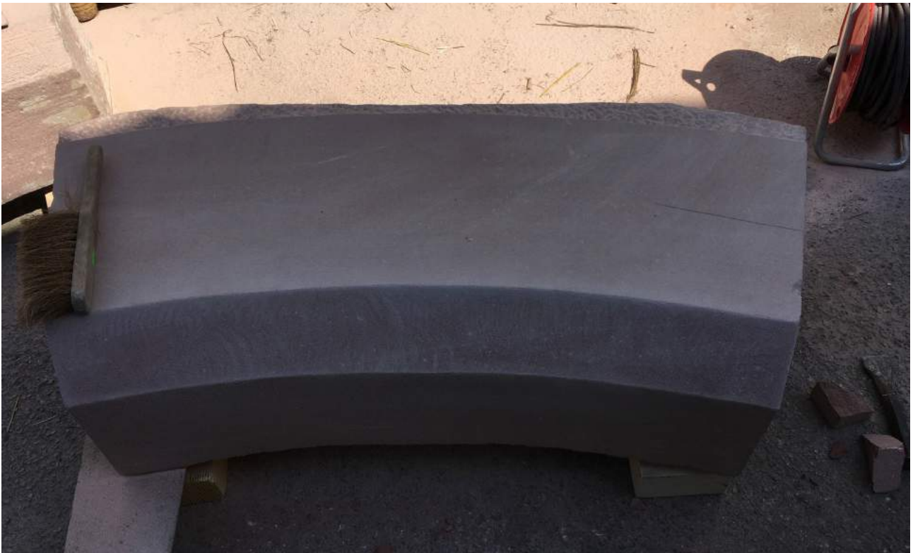
3.) Schalenbildung und Abschuppungen an dem Bogensegment L 2 und L 3
