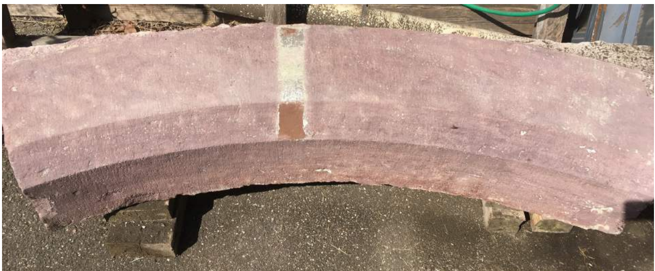
Oberes Bogensegment links (L 3) nach Freilegung im IOS – Verfahren
