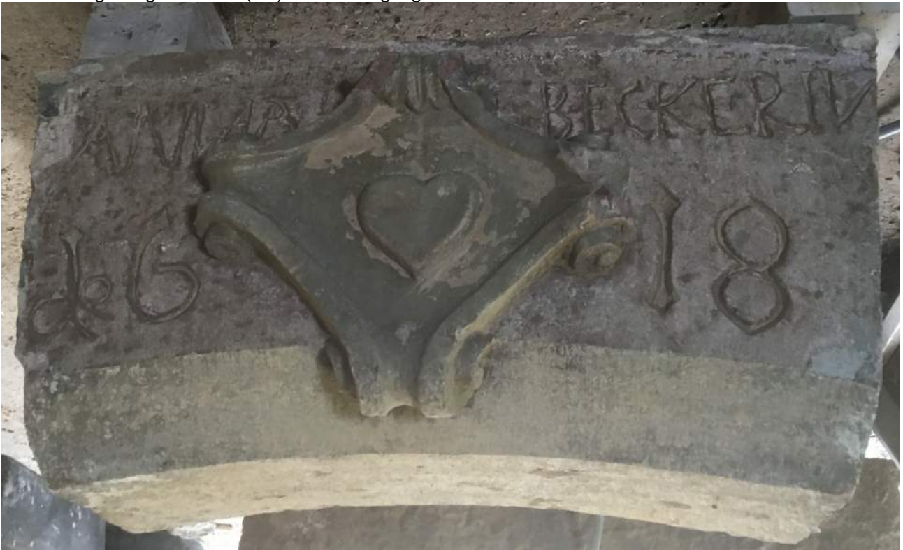
Unteres Bogensegment links (L 2) nach Freilegung im IOS-Verfahren
